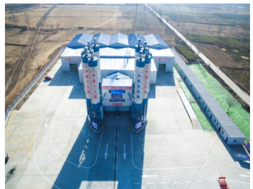
图 6.2.4-1 混凝土拌和站整体布局
